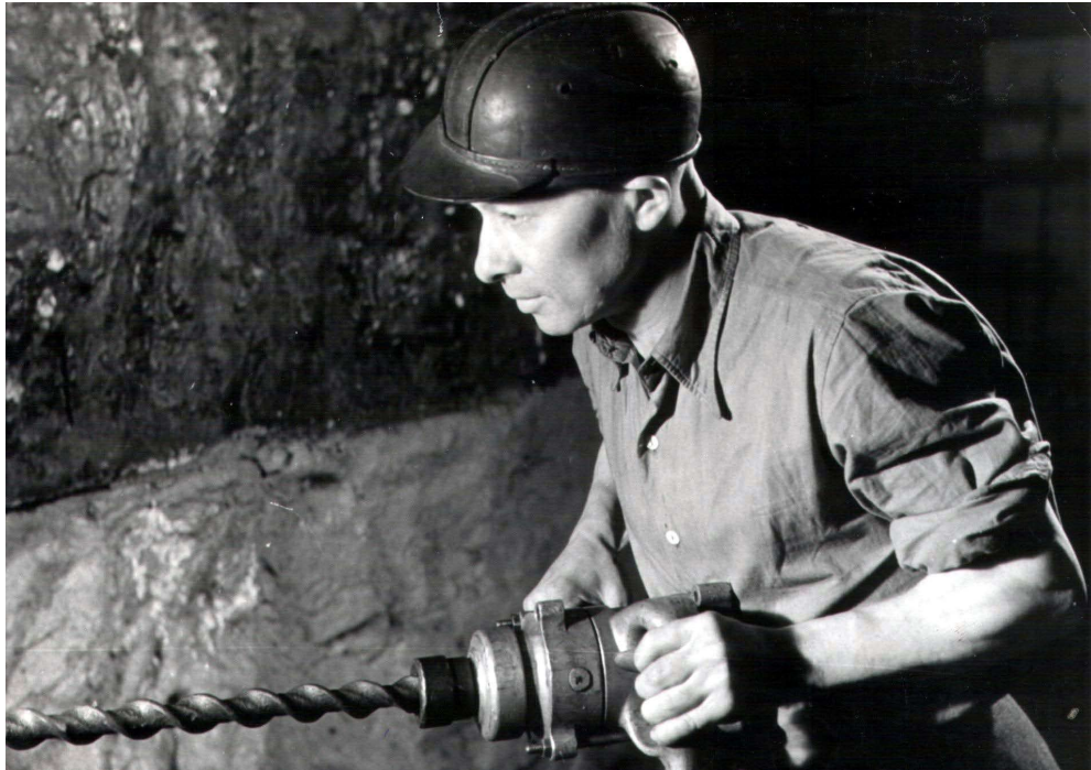
Fot. 5. Wiercenie wiertarką pneumatyczną. Fot. ze zbiorów Autora. Autor fotografii nieznan
