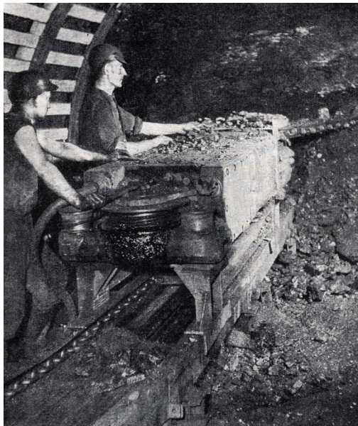
Fot. 8. Wrębiarka chodnikowa podczas pracy.
