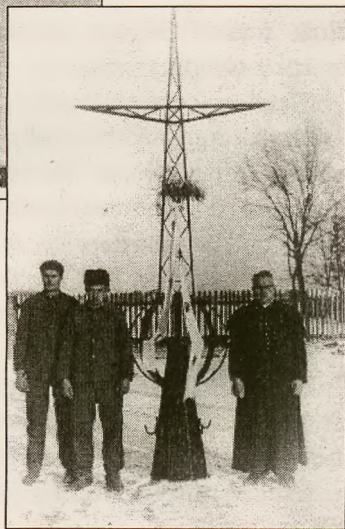
Zakończenie wieży z kościoła w Kolonii. Stoją od lewej: H. Kandziora, P. Bącz i ks. dziekan A. Kaleja
