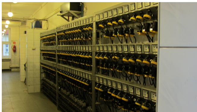
lampownia - miejsce ładowania i pobierania lamp górniczych przed zjazdem na dół; zdjęcie: autor
