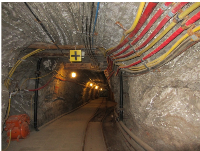
Chodnik ze zwężką skałą - bez obudowy. Kopalnia Soli w Bochni; zdjęcie: autor.
