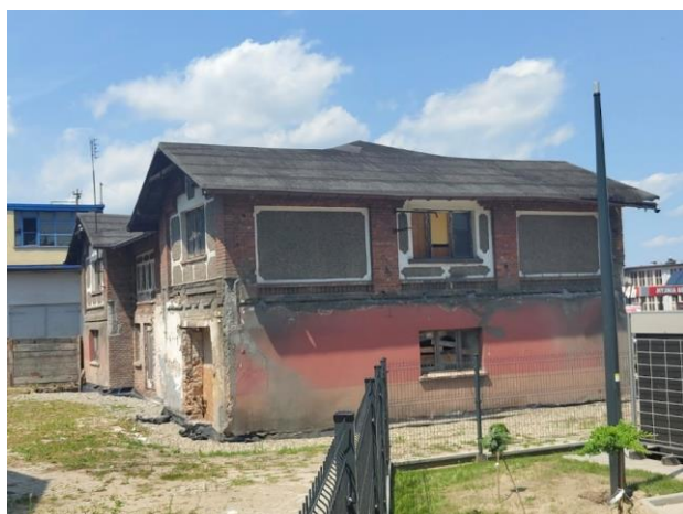
Fot. 14. Remont budynku stacji ratowniczej (2024)
