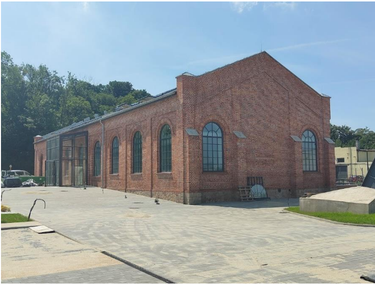
Fot. 7. Budynek maszyny wyciągowej Jan (lipiec 2024)
