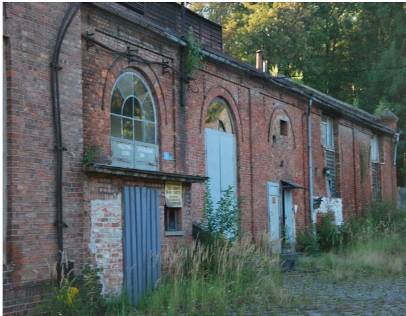
Fot. 5. Budynek maszyny wyciągowej i łaźni kobiet (2017)
