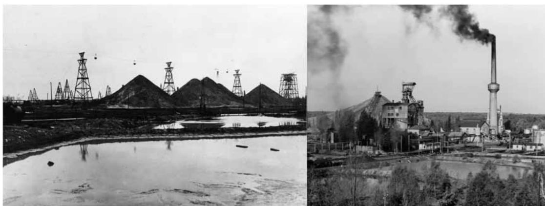
Rys. 8. Transport odpadów przerobczych na zwałowiska, w głębi szyby naftowe (po lewej). Po prawej szyp główny podziemnej kopalni ropy naftowej [6]
