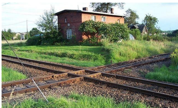
Skrzyżowanie kolejowe pod kątem prostym w Orzeszu.
