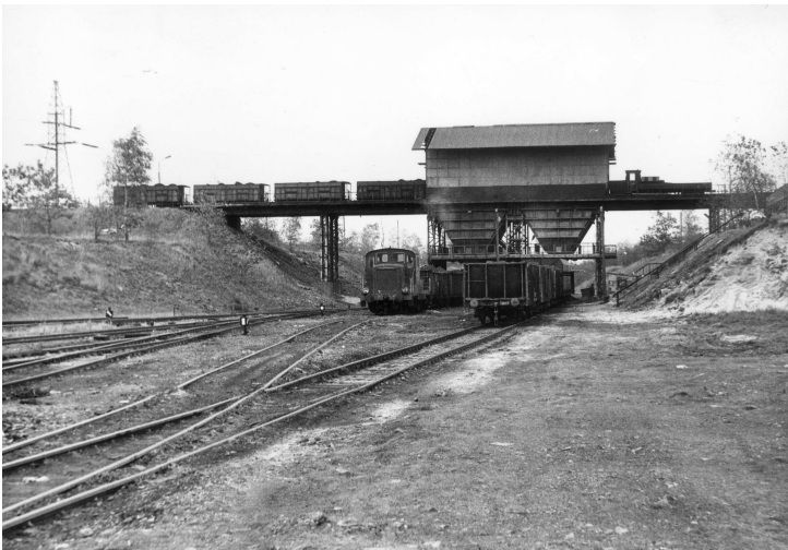
Przeładownia z wagonów wąskotorowych na wagony normalnotorowe, stacja Huta Miasteczko Śl - uległa likwidacji, zanim ktokolwiek pomyślał, że mogłaby rozwiązać częściowo problem tranzytu ciężkich samochodów na drodze Bytom-Tarnowskie Góry (Foto: K. Soida 1985)
