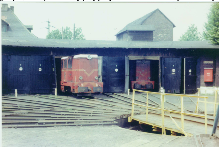
Rys. 6. Lokomotywownia w Maciejkowicach przetrwała przez 50 lat od 1942 do 1992 roku. (Foto. K. Soida 1985 r.)
