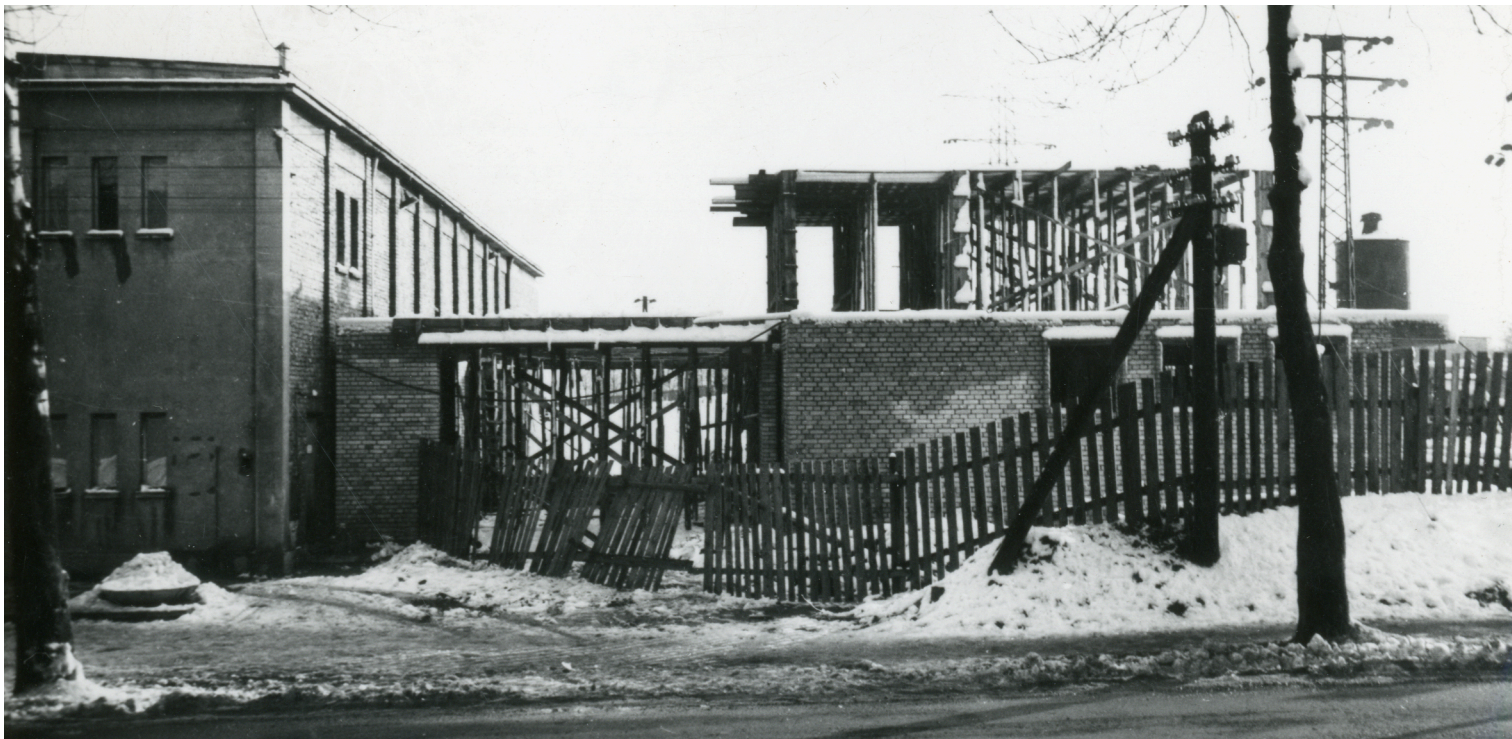
Budowa Domu Kultury w latach 60. XX wieku na podstawie projektu mgr. inż. Antoniego Czernowa
