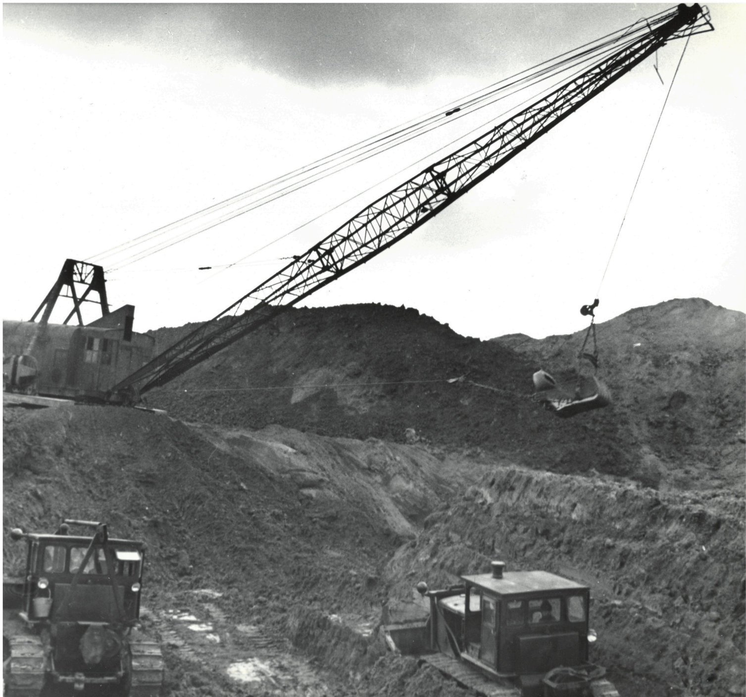
Prace odkrywkowe w Smardzowicach, 1959 r.
