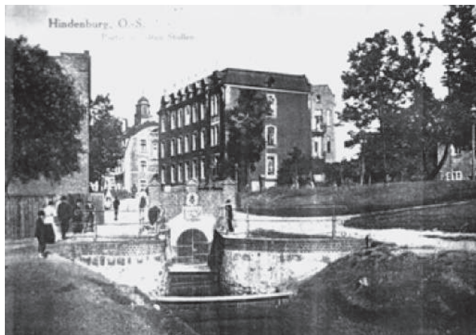
Portal wylotu Królewskiej Sztolni Dziedzicznej w Zabrzu – sztolnia spławnia służyła do transportu węgla koksującego z kopalni Królowa Luiza i kanałem sztolniowym do huty w Gliwicach, foto z pocz. XX w.
