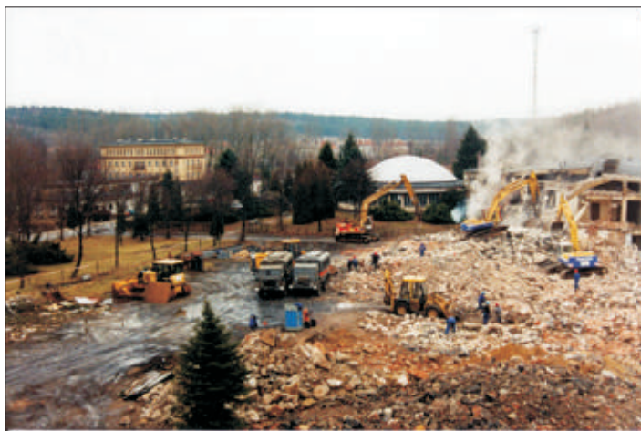
Likwidacja infrastruktury powierzchniowej kopalni "Konrad"
