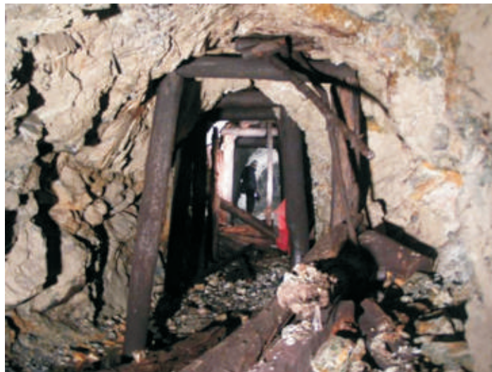
Pozostałości drewnianej obudowy wyrobisk
