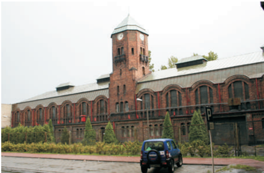
Budynek cechowni przy szybie "Pułaski", Katowice-Nikiszowiec
