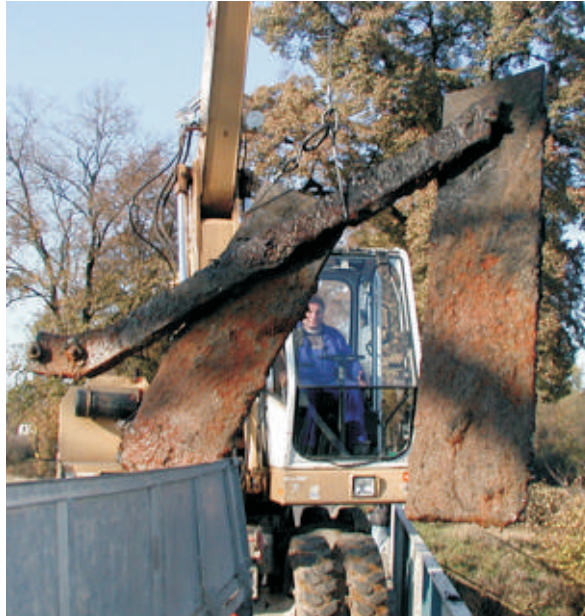
W trakcie prac archeologicznych wydobyto w 2004 r. z rzeki Strzegomki wiele elementów najstarszego na kontynencie europejskim mostu żeliwnego w Łażanach, 1796
