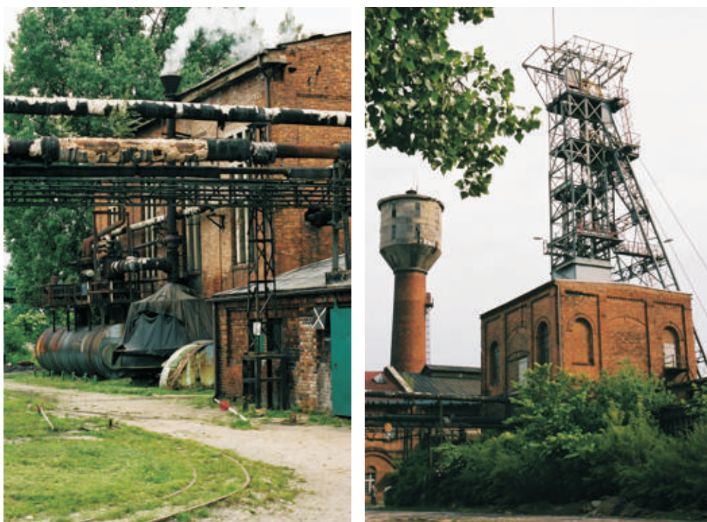
Kopalnia "Ignacy-Hoym" w Rybniku • budynek maszyny wyciągowej szybu "Głowacki" • szyb "Kościuszko"
