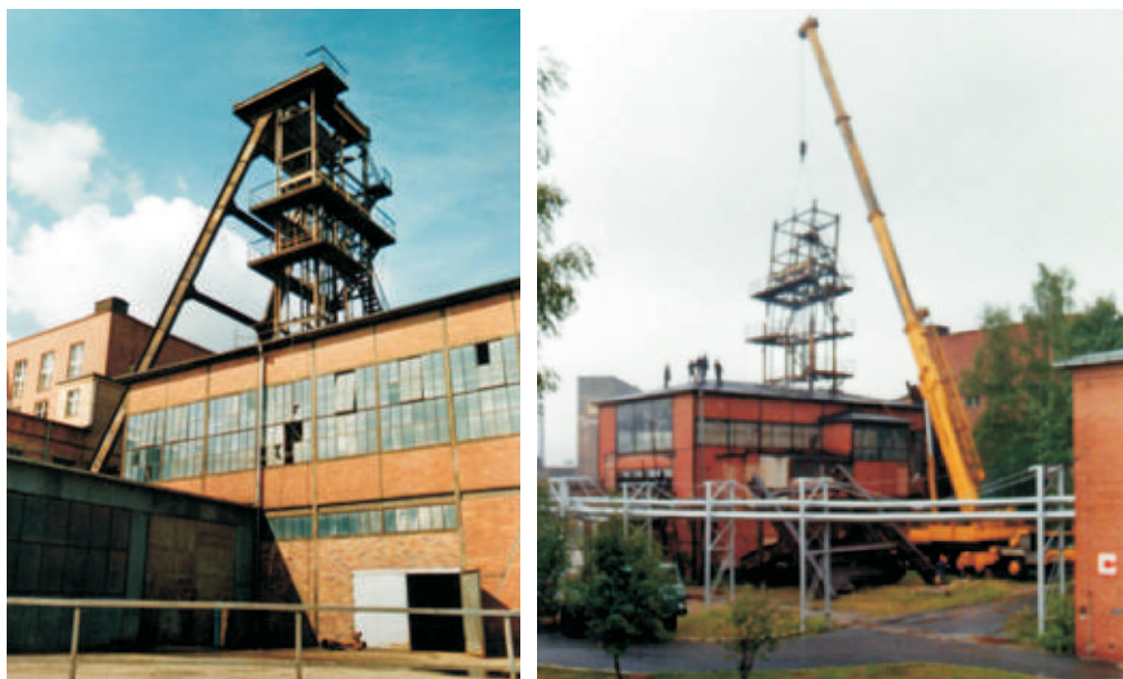
Szyb wydobywczy kopalni "Lena", likwidacja wieży szybowej
