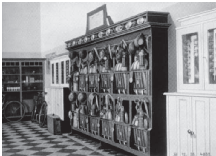
Centralna Stacja Ratownictwa Górniczego w Akwizgranie, ścianka na aparaty oddechowe "Dräger", 1924 i obok dwie szafy na ustniki, 1926; repr. z: Die Neuausrüstung des Rettungswesens an Ruhr und Rhein, "Draeger-Hefte" 1927, nr 116, s. 1249
