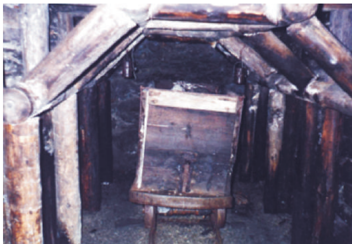
Wózek w zrekonstruowanym wyrobisku w obudowie drewnianej, foto autor
