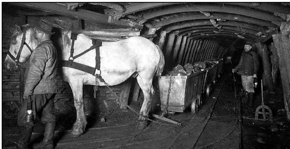
Foto 4. Transport urobku zaprzęgiem konnym
