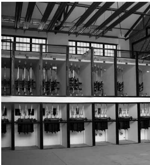
Budynek rozdzielni elektrycznej 6 kV po rewitalizacji. Fot. J. Jurkiewicz
