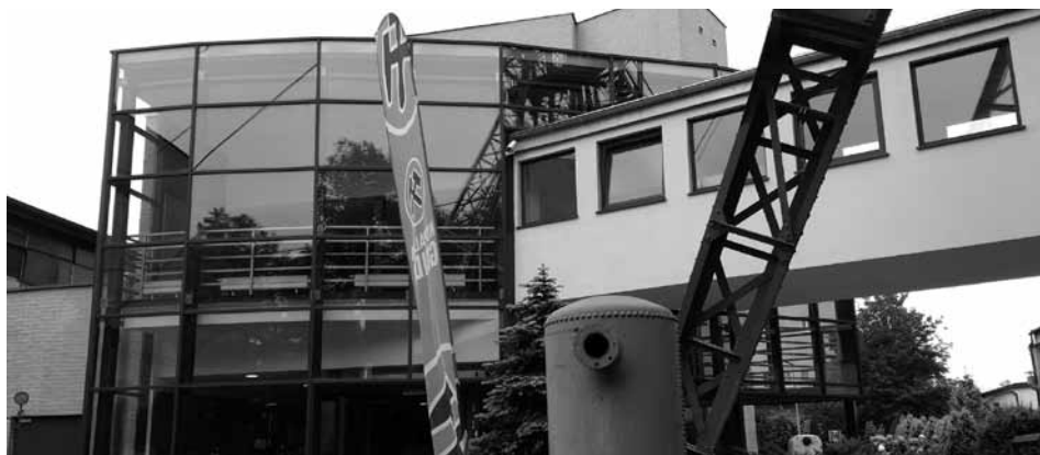
Budynek obsługi ruchu turystycznego kop. „Guido” po przeprowadzonym remoncie i rozbudowie. Fot. A Mitek
