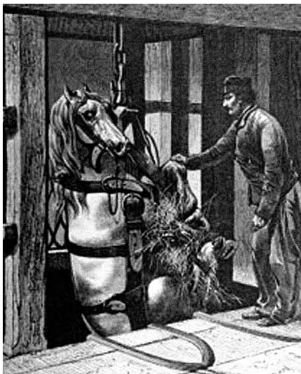
Foto 6. Opuszczanie konia szybem na dół
