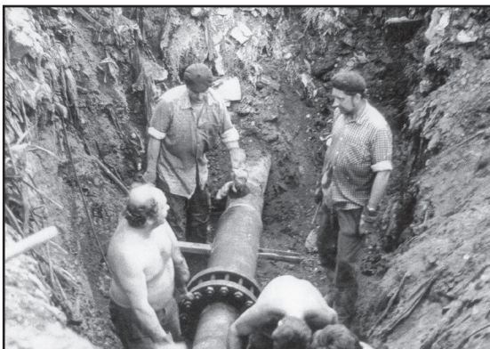
Fot. 10. Usuwanie awarii gazociągu, lata 80. XX wieku. Archiwum GSG Zabrze
