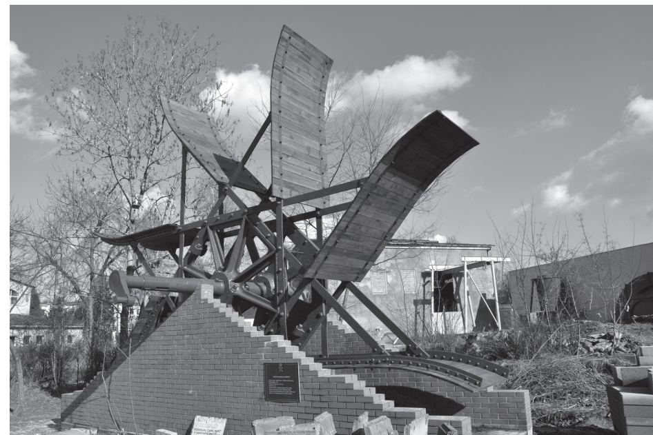
Fot. 14. Wentylator Guibald po konserwacji, kopalnia „Królowa Luiza” – ul. Sienkiewicza w Zabrze. Fot. J. Jurkiewicz
