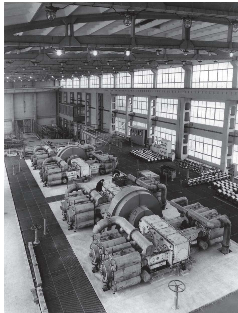
Fot. 11. Zakład Przesyłu Gazu Koksowniczego w Częstochowie Kompresory Boxer, produkcja NRD Halberstadt 1967, Ze zbiorów Adama Frużyńskiego
