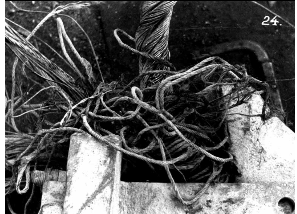
Fot. 4. Rozplecione splotki zniszczonej liny nośnej. Fot. ze zbiorów Archiwum Państwowego w Katowicach
