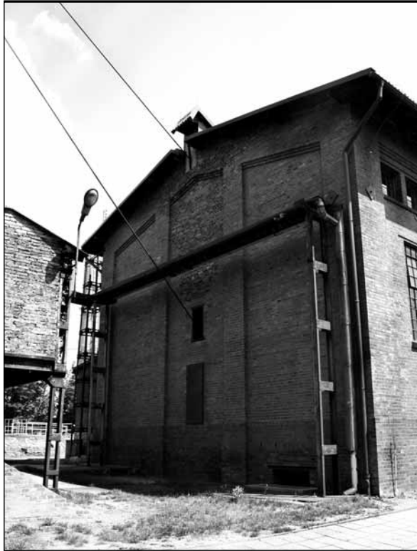
Fot. 14. Ślady wykonanej naprawy ściany szczytowej budynku maszyny wyciągowej. Fot. Jan Woźniak, 2009 r.
