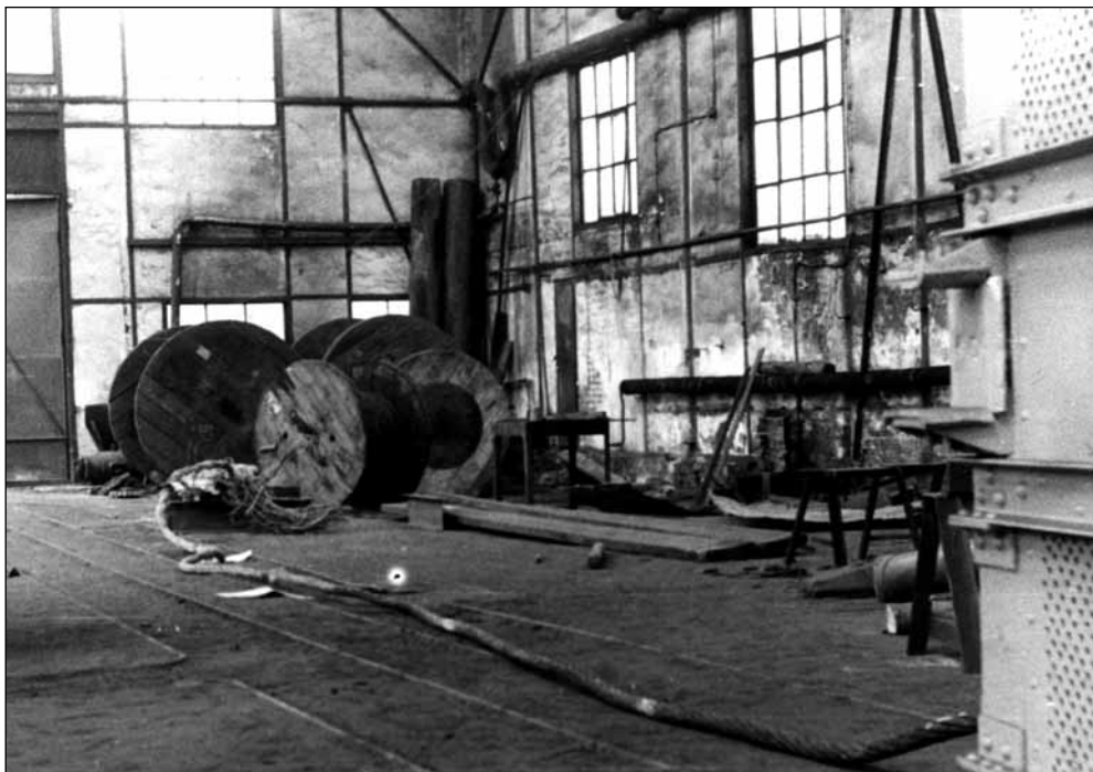
Fot. 7. Zniszczona lina nośna z zawieszem klatki południowej, przeniesiona z budynku maszyny wyciągowej na nadszybie. Fot. ze zbiorów Archiwum Państwowego w Katowicach
