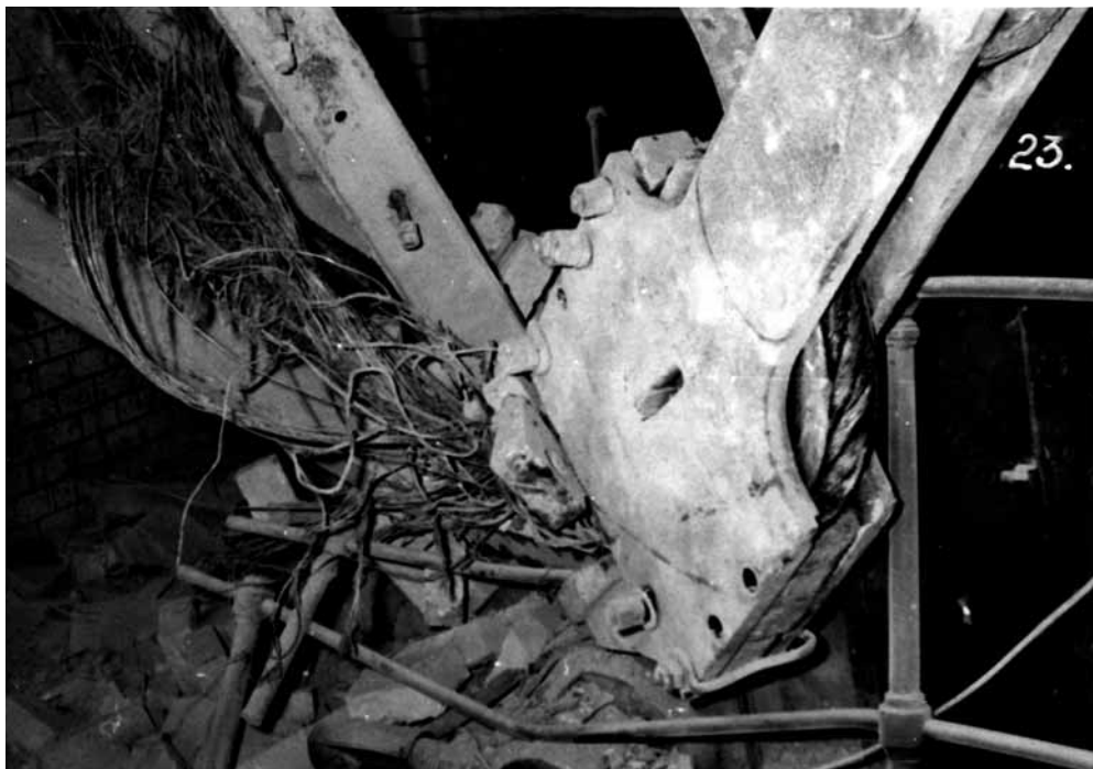
Fot. 3. Zawiesie liny nośnej klatki południowej zaklinowane w szczęce hamulcowej koła pędnej maszyny wyciągowej. Fot. ze zbiorów Archiwum Państwowego w Katowicach
