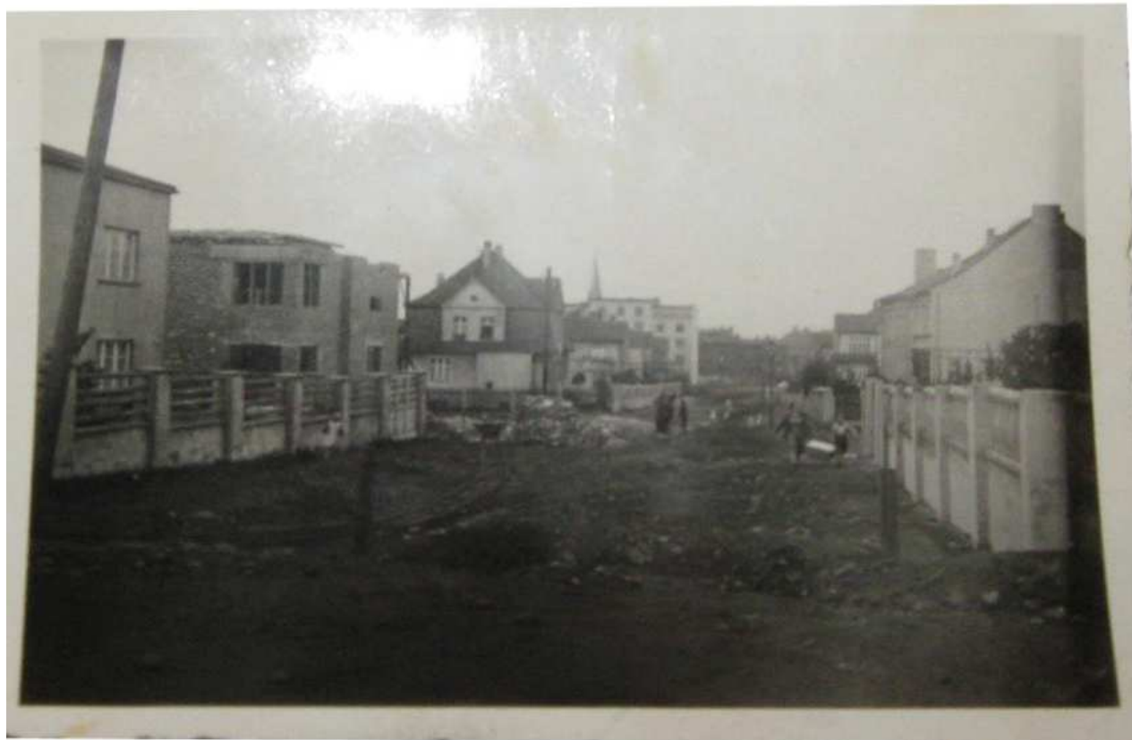
Fot. 3. Budowa osiedla Zachęta. Ul. Wojska Polskiego, lata 30' XX wieku (źródło: zbiory własne).
