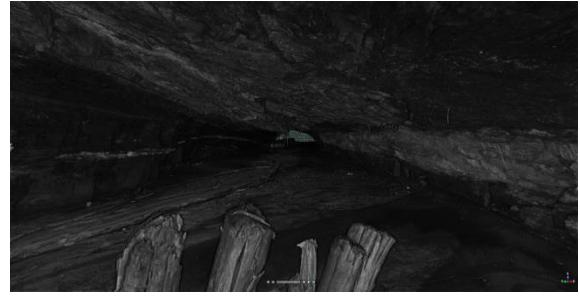
Rys. 5. Widok pustki po eksploatacji systemem zabierkowym z zawalem stropu
