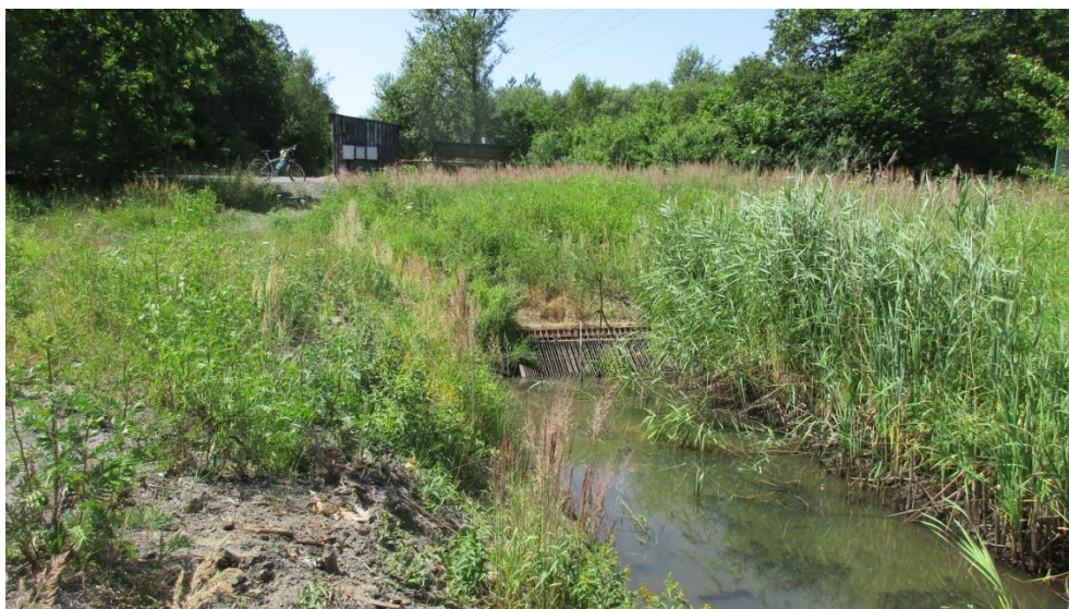
Fot.2. Odslonięty kanał do studni wlotowej rurowciągu lewarowego od strony zalewiska W3/64 na potoku Książenickim.
