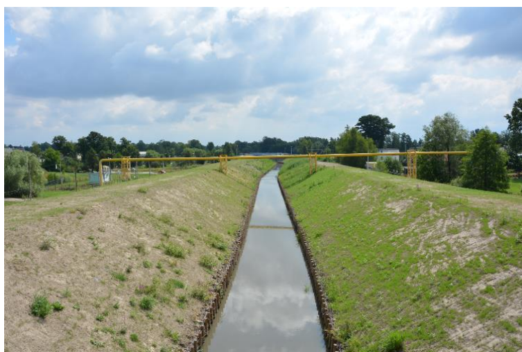
Rys. 7. Wykonane prace w korycie rzeki Pszczyńki
