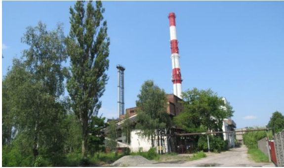
Foto 13. Ciepłownia kop. "1 Maja".
