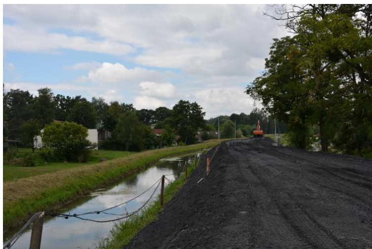
Rys. 10. Potok Pawłówka - nadbudowa istniejących obwałowań potoku Pawłówka
