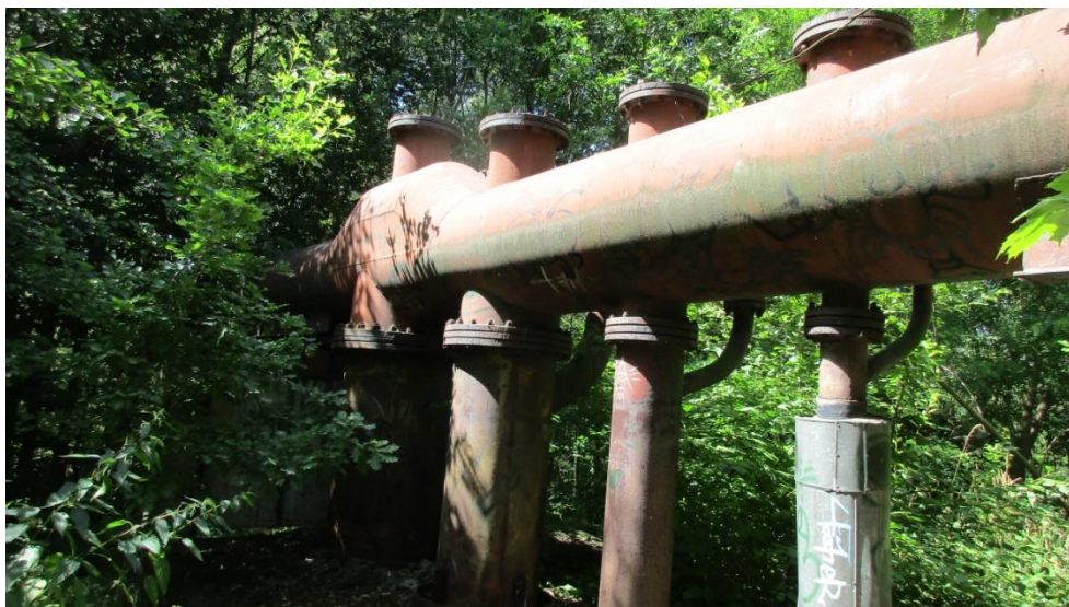
Fot.8. Komora rozprężna ruropociągu lewarowego w rejonie koryta potoku Wilcza II.
