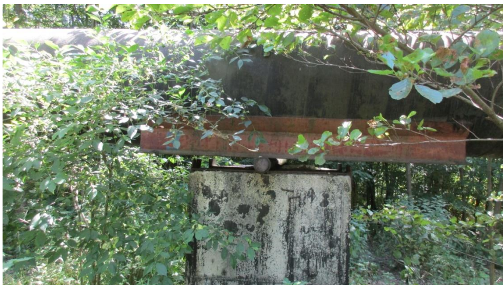
Fot. 6. Rurociąg lewarowy \varnothing 800 ; szczegół podpory ruchomej tocznej.
