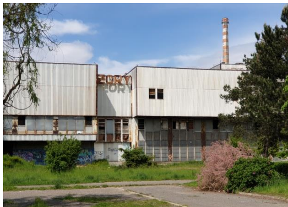
Foto 18. Budynek administracji z salą widowiskową.
