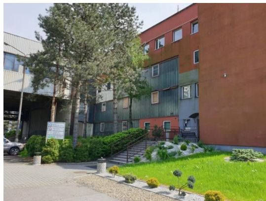
Foto 19. Budynek biur sztygarów z łaźnią.
