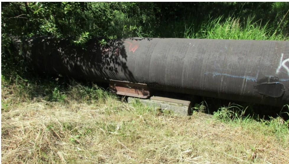
Fot. 5. Rurociąg lewarowy \text{Ø}800 ; widoczny przesuw rurociągu względem podpory ruchomej ślizgowej.
