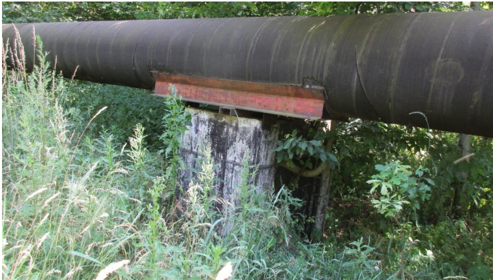
Fot. 4. Rurociąg lewarowy \text{Ø}800 ; szczegół podpory ruchomej ślizgowej.
