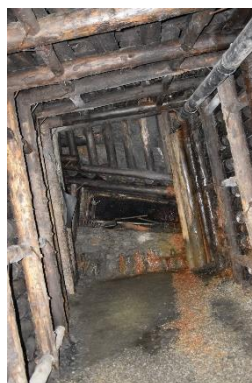
Rys. 3. Widok sztolni w obudowie drewnianej
