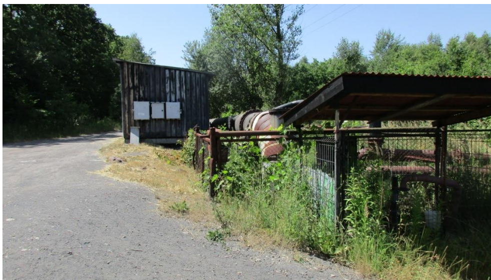
Fot. 3. Kolano wlotowe Ø800 rurowciągu lewarowego nad studnią wlotową.
