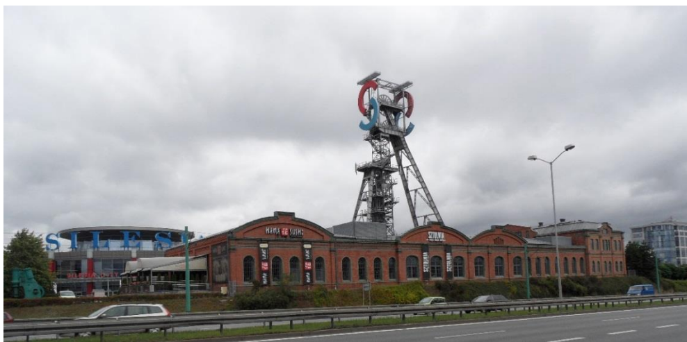
Fot. 2. Widok ogólny na obiekty przemysłowe (fot. E. Strzałkowska)
