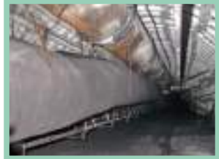
Montaż zawiesi trasy kolejki podwieszanej
