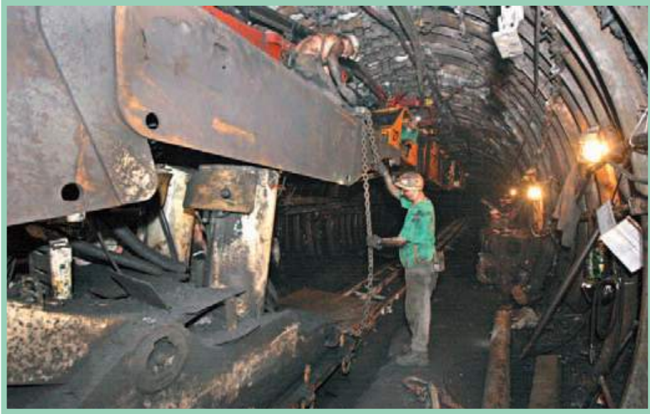
Roboty związane z przemieszczeniem ścianowej obudowy zmechanizowanej typu BUCYRUS 2600/5500
