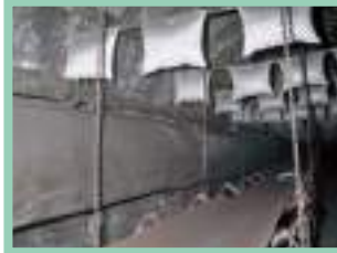
Montaż zawiesi trasy kolejki podwieszanej
