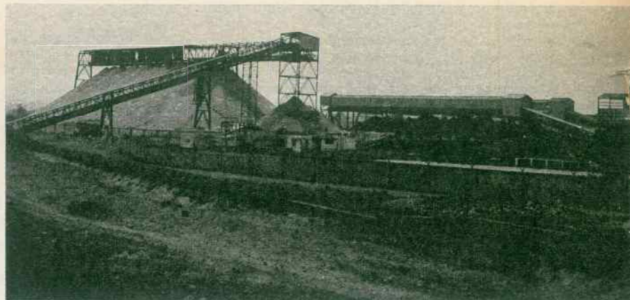
Piasek podsadzkowy dla kopalni w Sudamdihu wydobywany jest z rzeki unikatową metodą hydrologiczną
