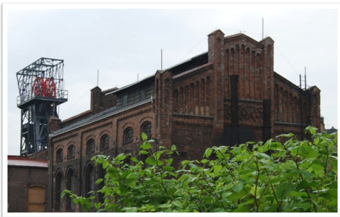
Kompleks wydobywczy szybu Bartosz: wieża wyciągowa- budynek parowej maszyny wyciągowej. Widok z roku 2000.
