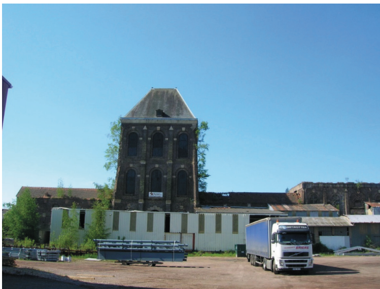
Rys. 22. Epinac – szymb puits Hottinguer, gl. 558 m, z wieżą szymbową typu Malakof Fig. 22. Epinac – shaft puits Hottinguer, 558 m. deep with Malakof type headframe
